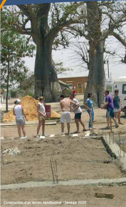
Construction d'un terrain handibasket - Senegal 2005
