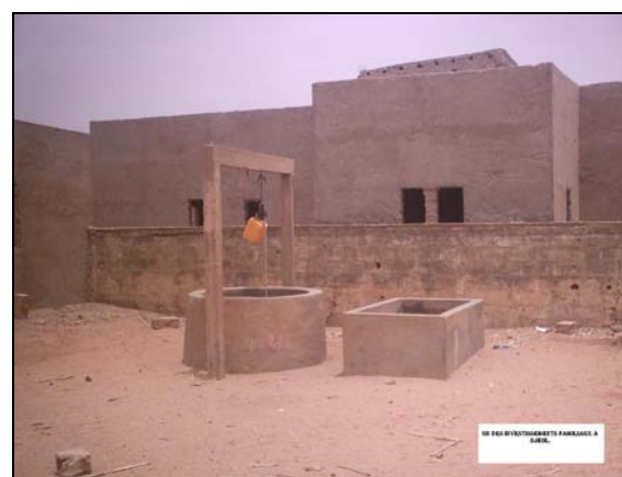
La construction de puits, partie essentielle de l'aménagement de l'habitat à Djéol.
